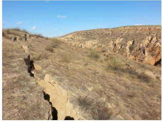
A10 测点地表裂缝
