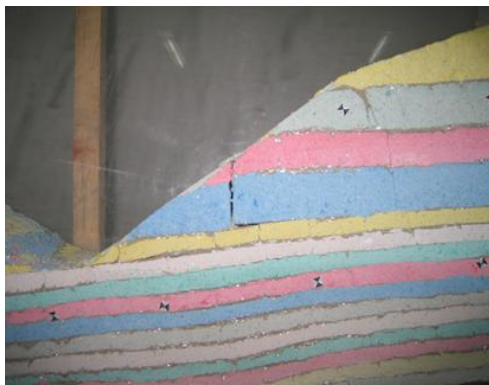
右侧山体裂缝
