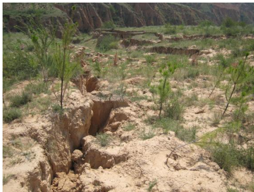
E11 测点附近裂缝
